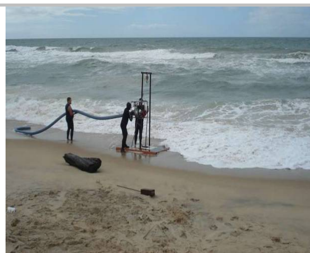
FOTO 6.3.7.7-4: Instalação do equipamento para amostragem na linha de praia. Tubulação em azul para captar água do mar.
